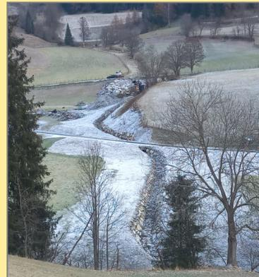
In die alte Grabenführung des Kummalitzengrabens wurde die Wasserleitung und die Stromleitung für den Sportplatz gelegt. Auch konnten in diesem Bereich und entlang der Straße bereits Leerrohre für die Salzburg AG mitgelegt werden,
