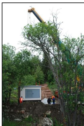
Der Lichtwellenleiter (LWL) ist zur Gemeinde gelegt. Die Grabungsarbeiten aufgrund der Verlegung des Stromkabels und LWL im Bereich der Gemeindestraße nach Mariapfarr und Wassering sind abgeschlossen. Die neue Trafostation in Fern ist errichtet, ebenso wurde dort die Stromversorgung (Weißhaupt, Hiasn) ins Erdreich verlegt. Der Breitbandausbau geht unverzüglich weiter.
